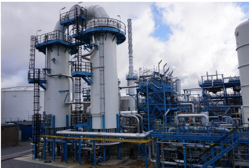
Raffinaderiets anläggning för produktion av vätgas.
